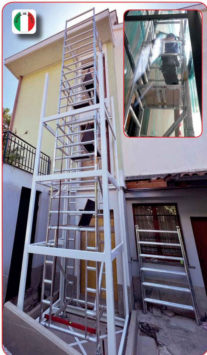
TEMPO LIFT montato all'interno di un vano ascensore
