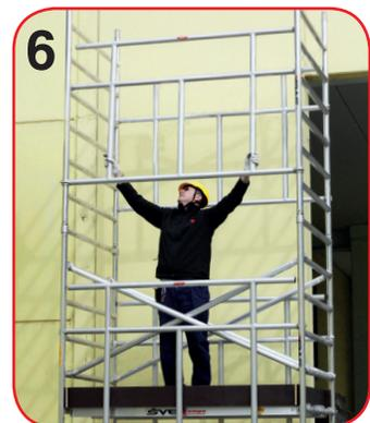
Una volta montato il piano la ringhiera di protezione di 1 m è già pronta in opera
